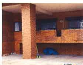
タイルの除去し、モルタル下地が完了して、新しいタイルを施工
