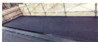
木造3階建の屋根・塗装工事実施後
