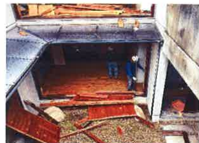
鉄筋造の建物の内装材・窓サッシの解体工事中
