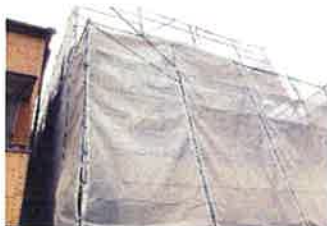
木造3階建 外壁工事前の足場組立工事完了
